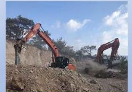
Scavi in superficie
