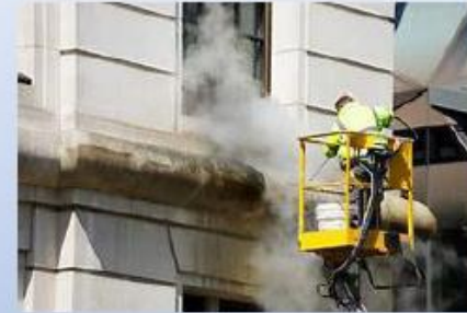
Pulizia superfici di edifici
